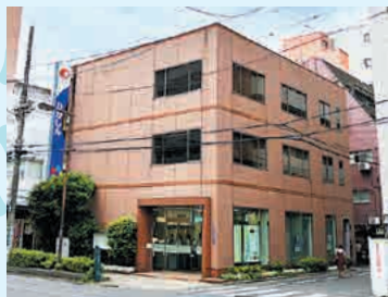
新堀通りに面した三筋支店。多くの方が利用しています。
